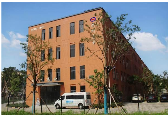
高电办公试验大楼
